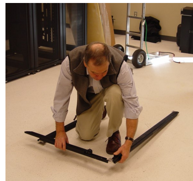
6. Assemble door frame
