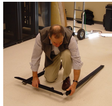
6. Assemble door frame
