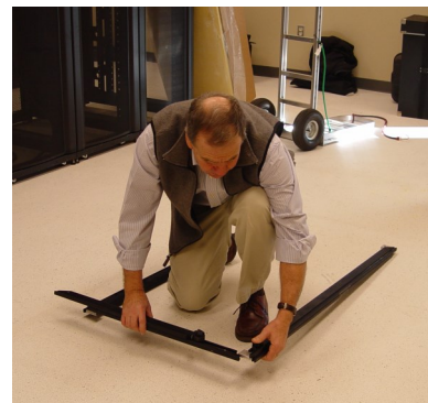
6. Assemble door frame
